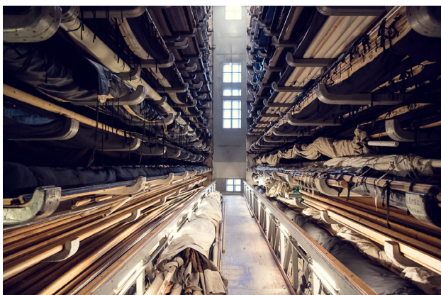
Ljuset i tunneln? Foto: Sören Vilks
